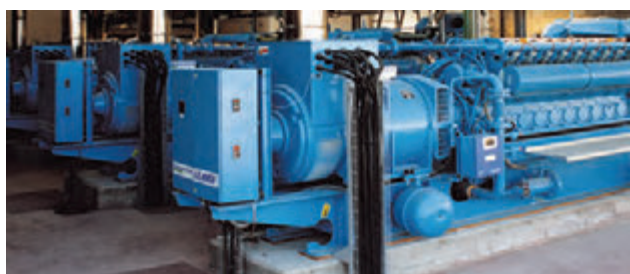
Виброизоляция генератора с помощью Vibrofix Block
