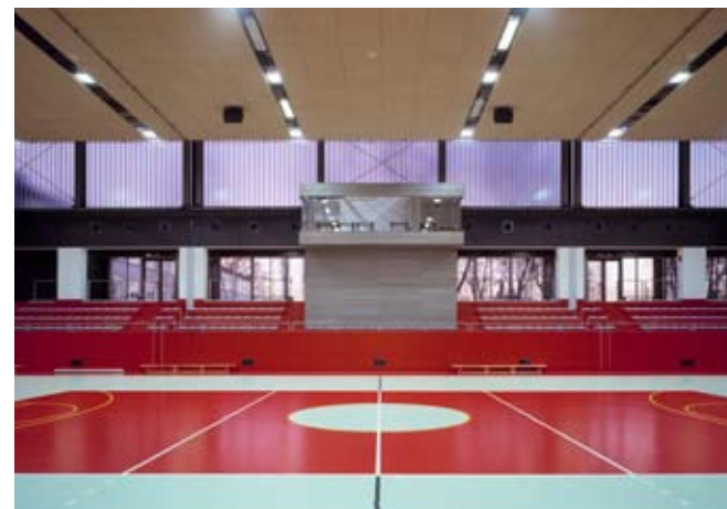
Акустический подвесной потолок Heradesign в многоцелевом спортивном зале г. Биерун, Польша
