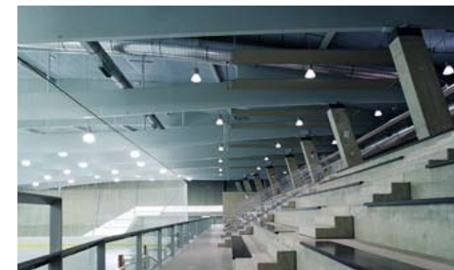
Акустическая отделка потолка ледовой арены панелями Heradesign Fine
