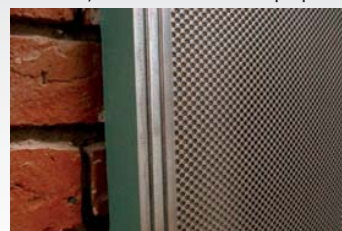
Стык панелей, использование Ω-профиля
