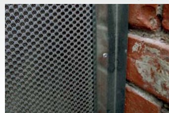
Крепление панели к стене и монтаж П-профиля
